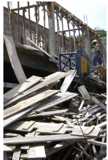
Så här såg det ut när skolan i Grassfield byggdes på. Lägg märke till basketkorgen mitt i allt formsättningsvirke. Det blev inget basketspel under byggnadstiden.
